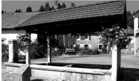
Au vu de l'expérience acquise, les services municipaux prépareront le chantier en assurant la destruction des bacs actuels (réalisées en mortier de ciment en 1899 en remplacement des auges antérieures qui étaient en bois), ainsi que la réalisation de nouveaux bacs en béton coffré, ceci avant le démarrage du chantier prévu le samedi 7 juillet (jusqu'au 28 juillet).
