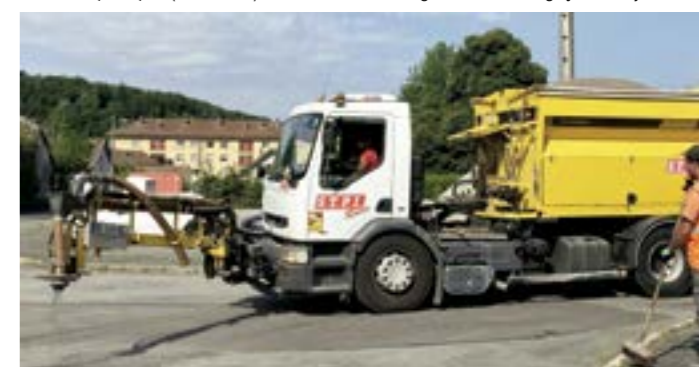
Campagne de réparation des chaussées au début du mois de juillet
