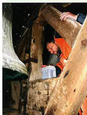
**Le diagnostic** préalable à la restauration de notre église a débuté. Un ingénieur structure est intervenu en utilisant un géophone pour enregistrer les vibrations du clocher lors des sonneries des cloches, afin de mesurer la réponse en fréquence de la structure. Nous vous informerons du résultat de cette « étude structure et vibratoire » et de la suite donnée.
