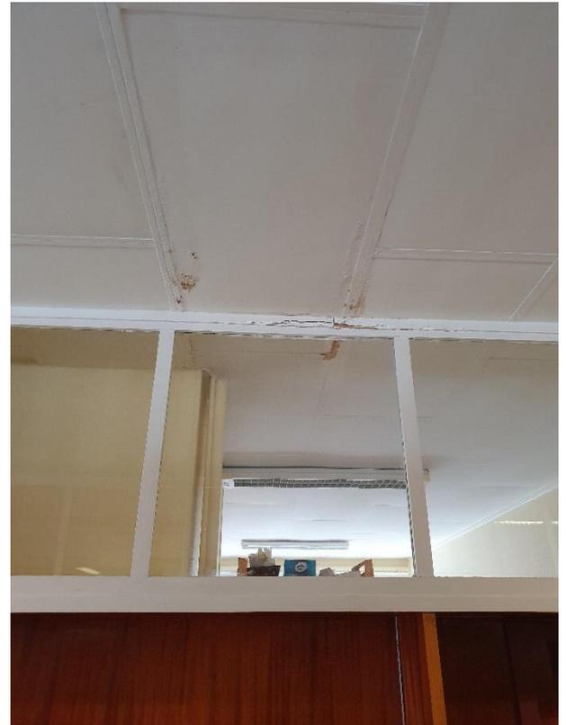
Figure n° 18 - Faux plafond avec trace d'humidité - couloir Nord R+1
