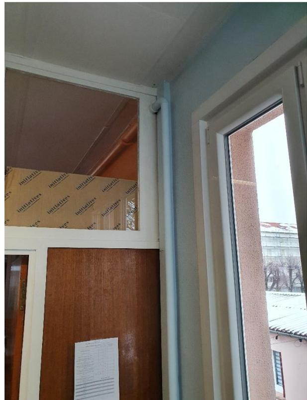
Figure n° 6 - Réseau d'eau chaude non calorifugé
