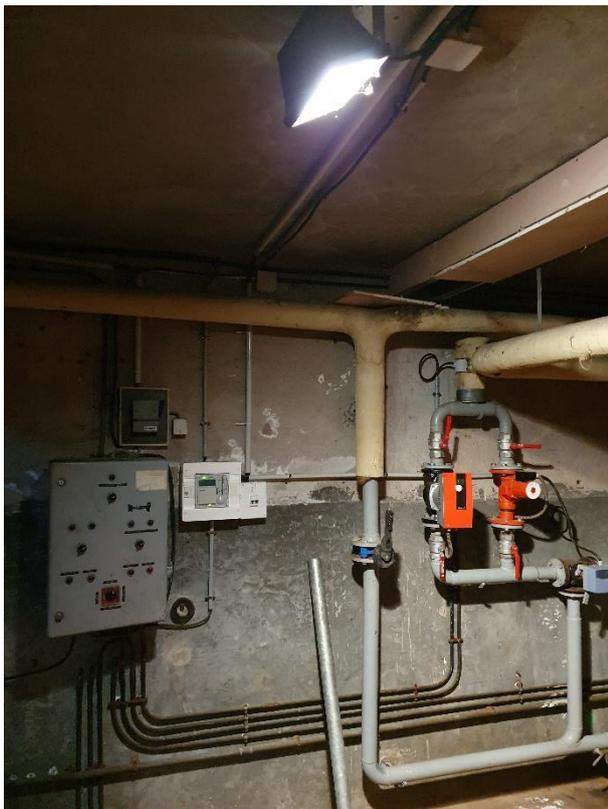
Figure n° 3- Réseaux de chauffage partiellement isolés
