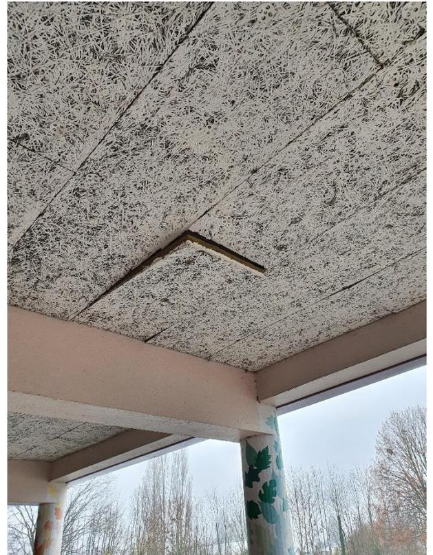
Figure n° 20 - Décollement d'une partie de l'isolant
