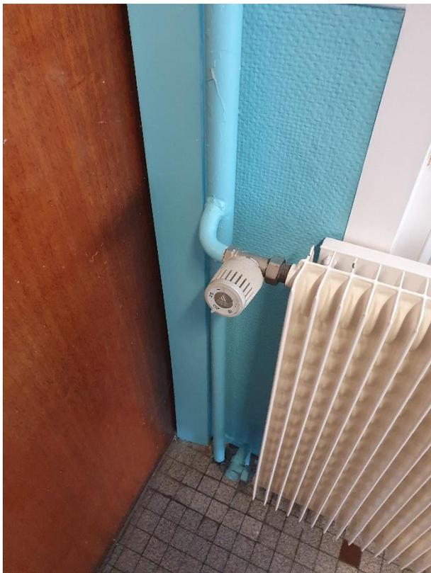
Figure n° 5 - Radiateur acier avec vanne thermostatique ancienne
