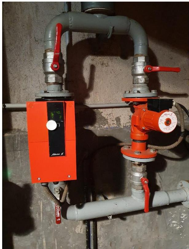
Figure n° 4 - Circulateur principaux
