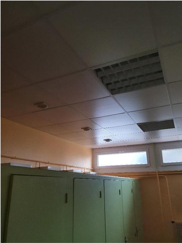
Figure n° 9 - Bouches d'extraction dans les sanitaires
